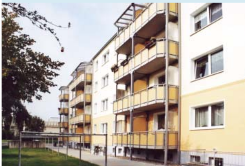
Zur Freude der Mieter wurden am sanierten Wohnblock An der Wasserrenne 33, 35 und 37 auch neue Balkone angebaut.
